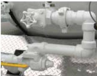
Las válvulas de derivación diferencial de Blackmer están diseñadas para proteger a las bombas y a los componentes del sistema de daños excesivos por presión, y ninguna instalación de bombas de gas LP está completa sin disponer de alguna de ellas. Blackmer ofrece cinco modelos diferentes que proporcionan un
